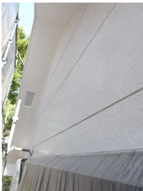
シーラー塗布後
