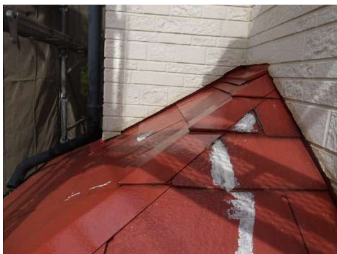
屋根下地処理後
