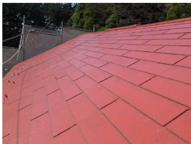
屋根プライマー塗布後
