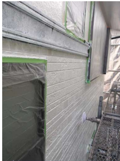
シーラー塗布後
