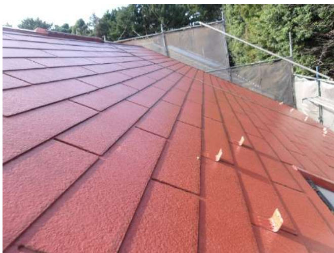
屋根プライマー塗布後
