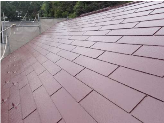
屋根上塗り後
