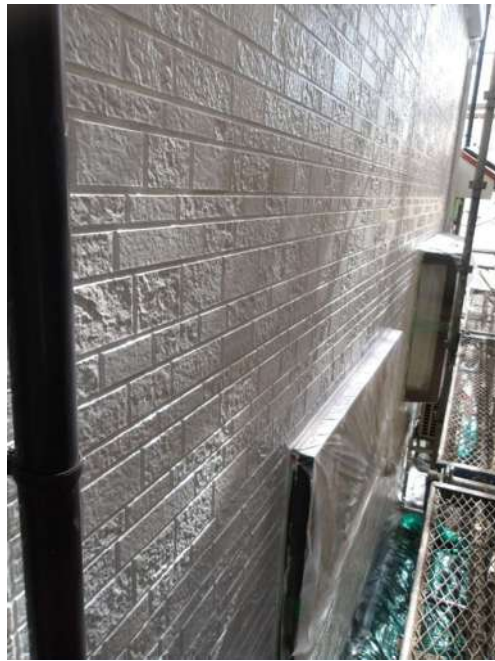
シーラー塗布後
