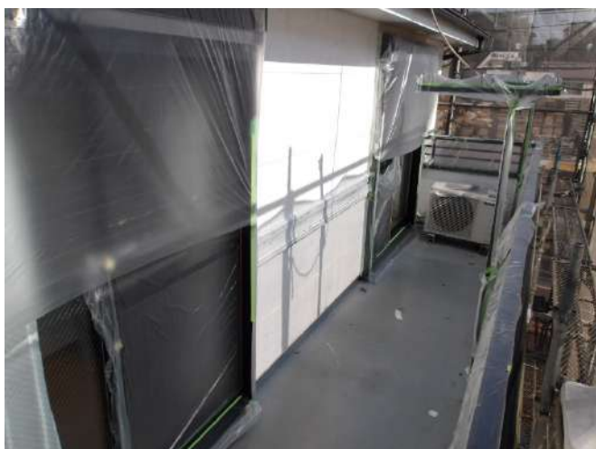
シーラー塗布後
