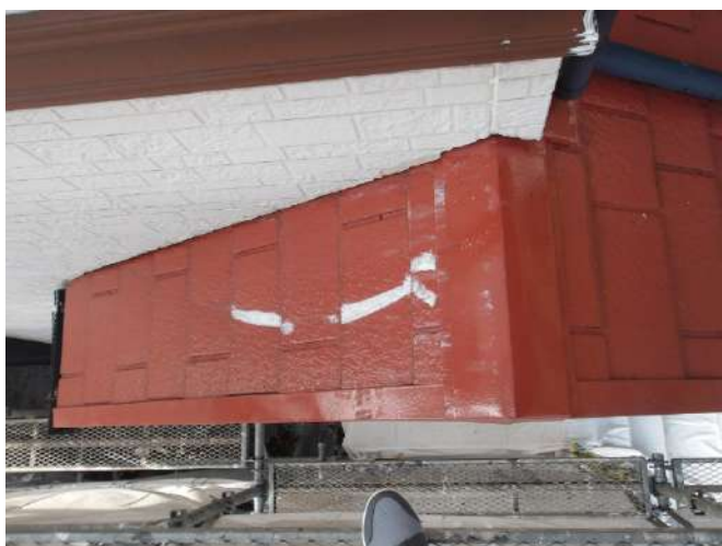
屋根下地処理後
