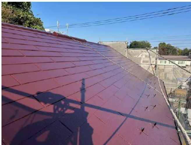
屋根上塗り後
