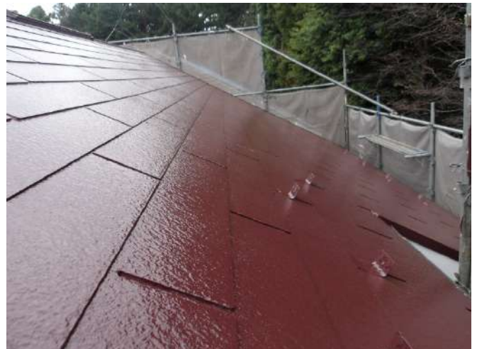
屋根上塗り後
