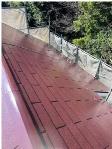
屋根上塗り後
