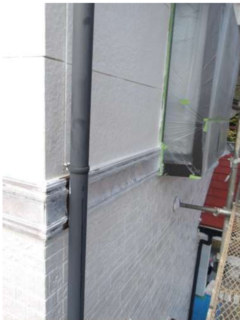
シーラー塗布後
