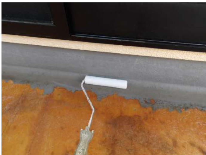
プライマー塗布中
