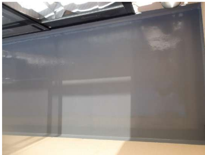
主剤塗布後トップコート仕上げ完了
