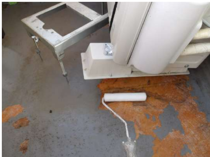
プライマー塗布中
