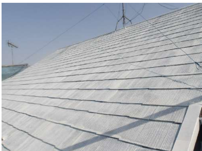
屋根下塗り後
