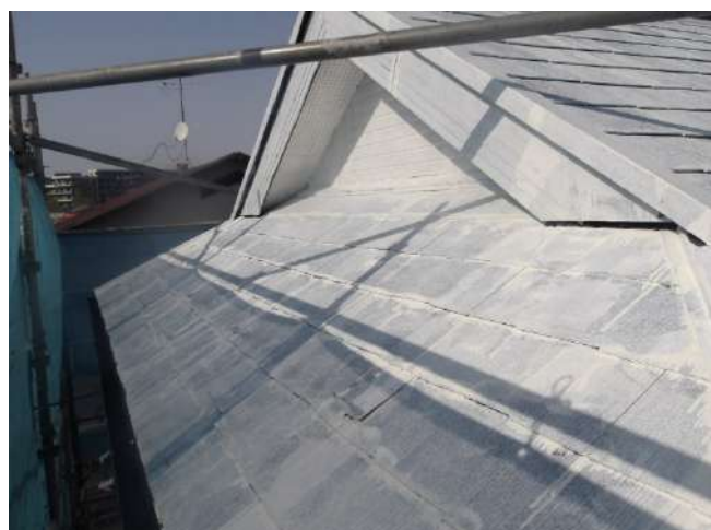
屋根下塗り後
