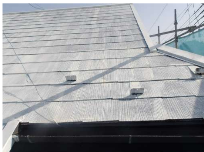
屋根下塗り後
