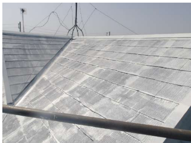
屋根下塗り後
