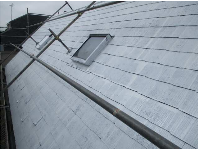
屋根シーラー完了
