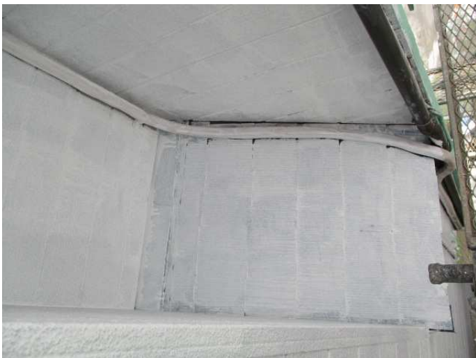
外壁シーラー完了
