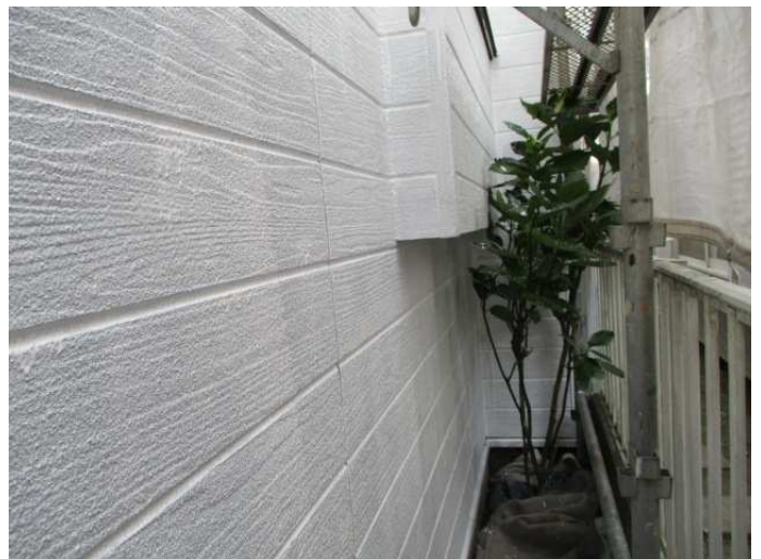
外壁シーラー完了
