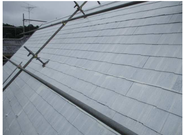
屋根シーラー完了
