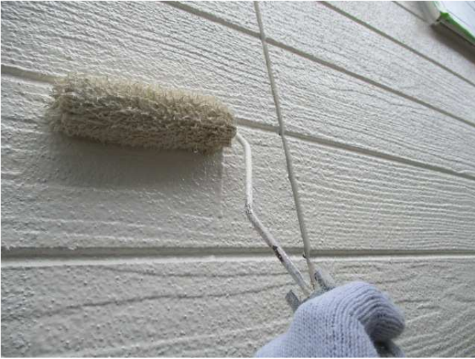
外壁上塗り中
