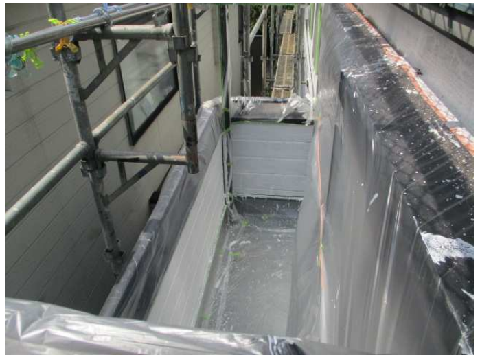
外壁シーラー完了
