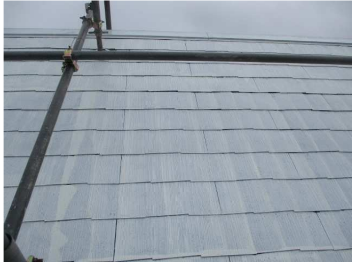
屋根シーラー完了
