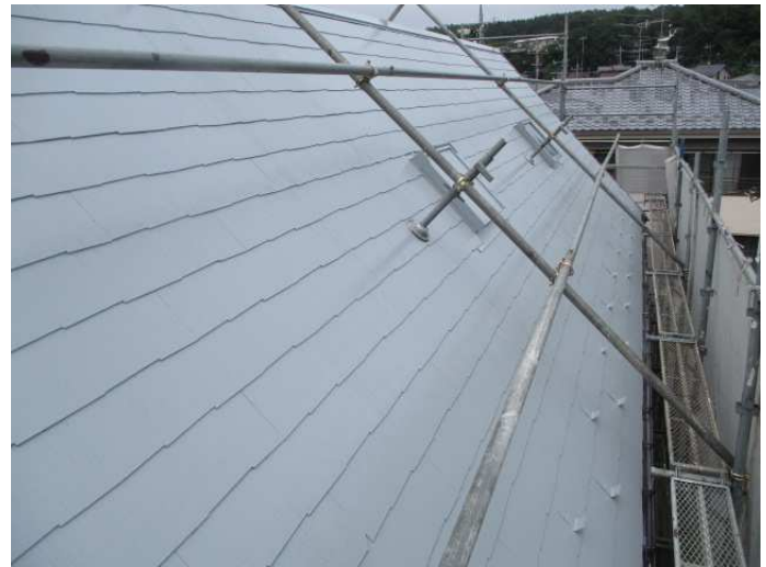
屋根中塗り完了
