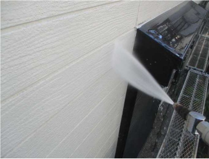
外壁高圧洗浄中
