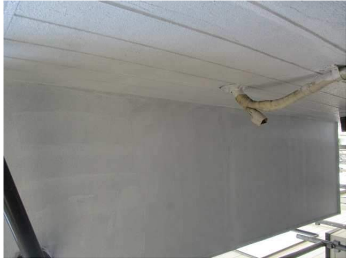
外壁シーラー完了
