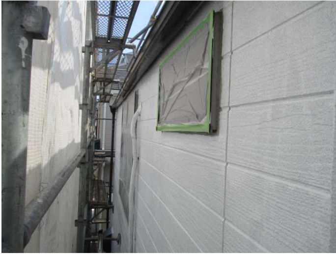
外壁シーラー完了
