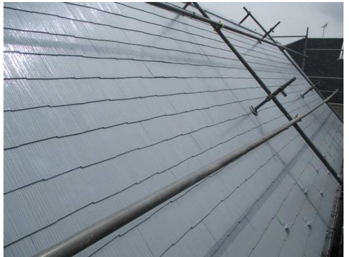
屋根上塗り完了
