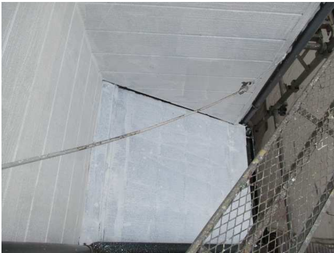
外壁シーラー完了
