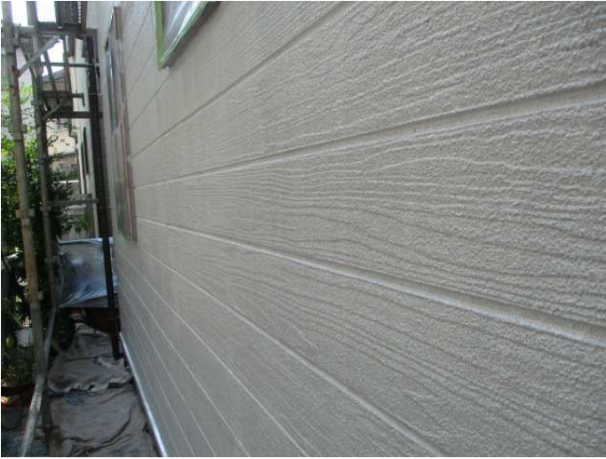
外壁シーラー完了
