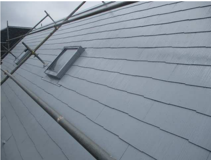
屋根中塗り完了
