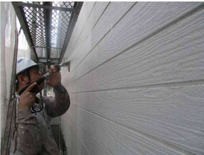
外壁高圧洗浄中
