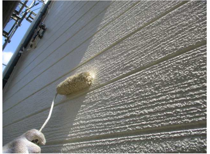
外壁上塗り中
