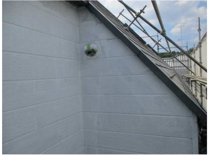
外壁シーラー完了
