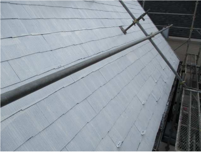
屋根シーラー完了
