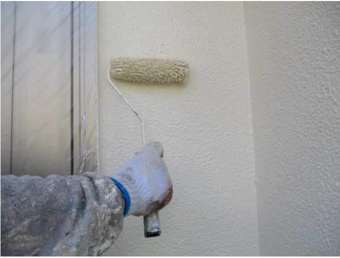
外壁上塗り中
