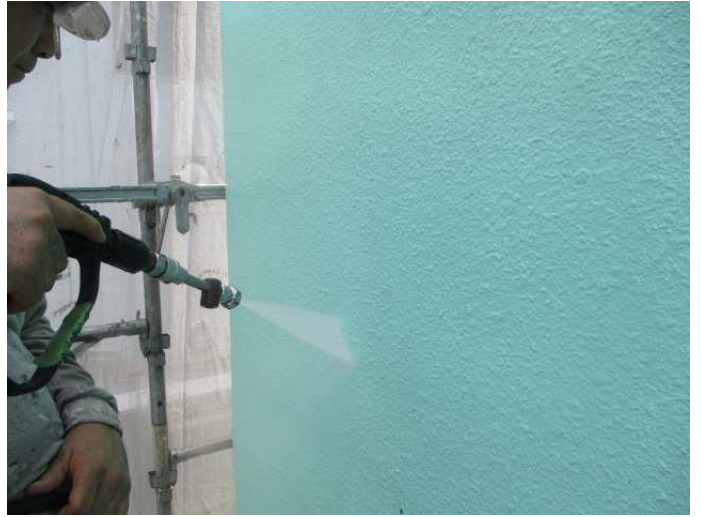
外壁高圧洗浄中
